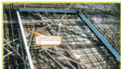
图五 卫生间高低差处理实物示意图
