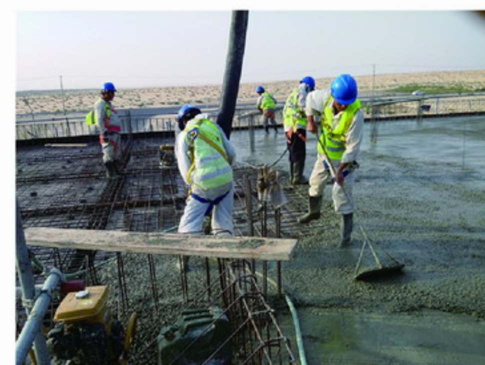
图：办公楼项目主体封顶砼施工现场
