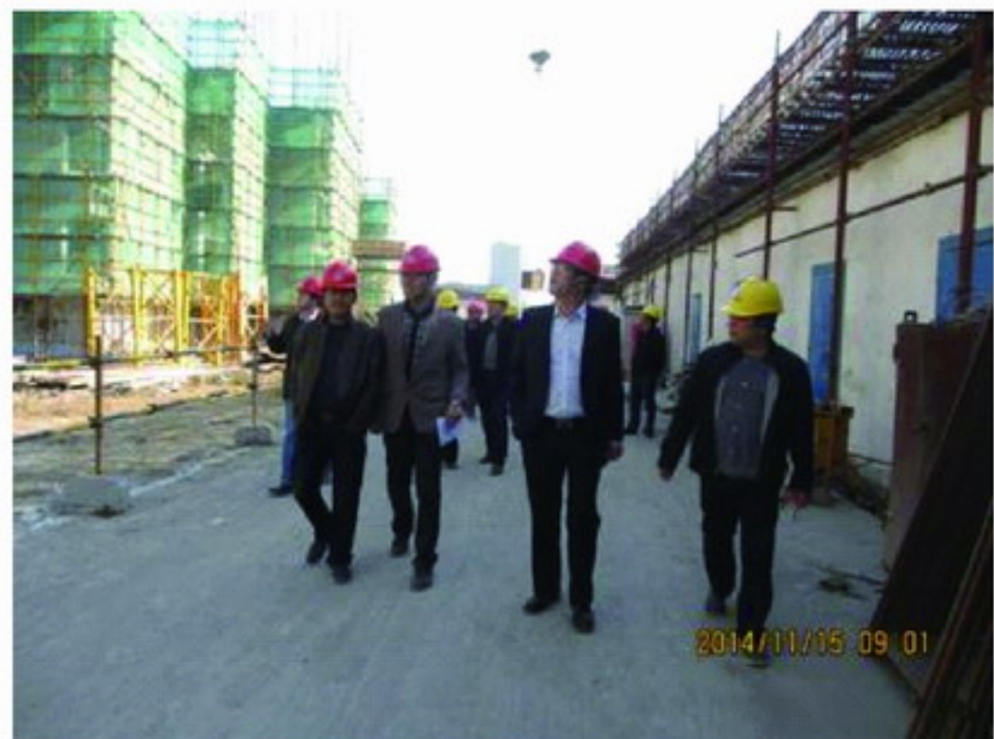
西郊雅苑项目部现场参观
