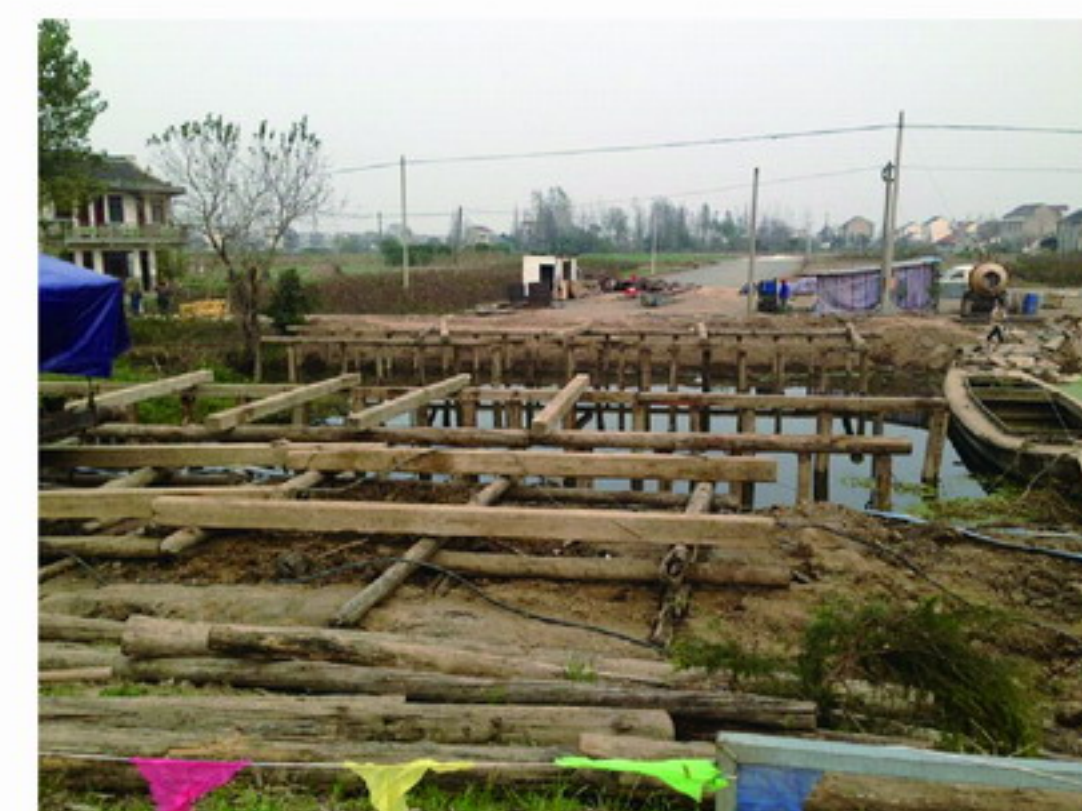
余东大新河桥施工现场
