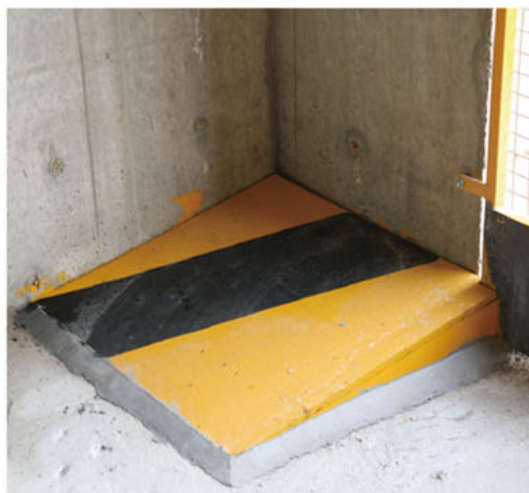
楼层内平台洞口防护
