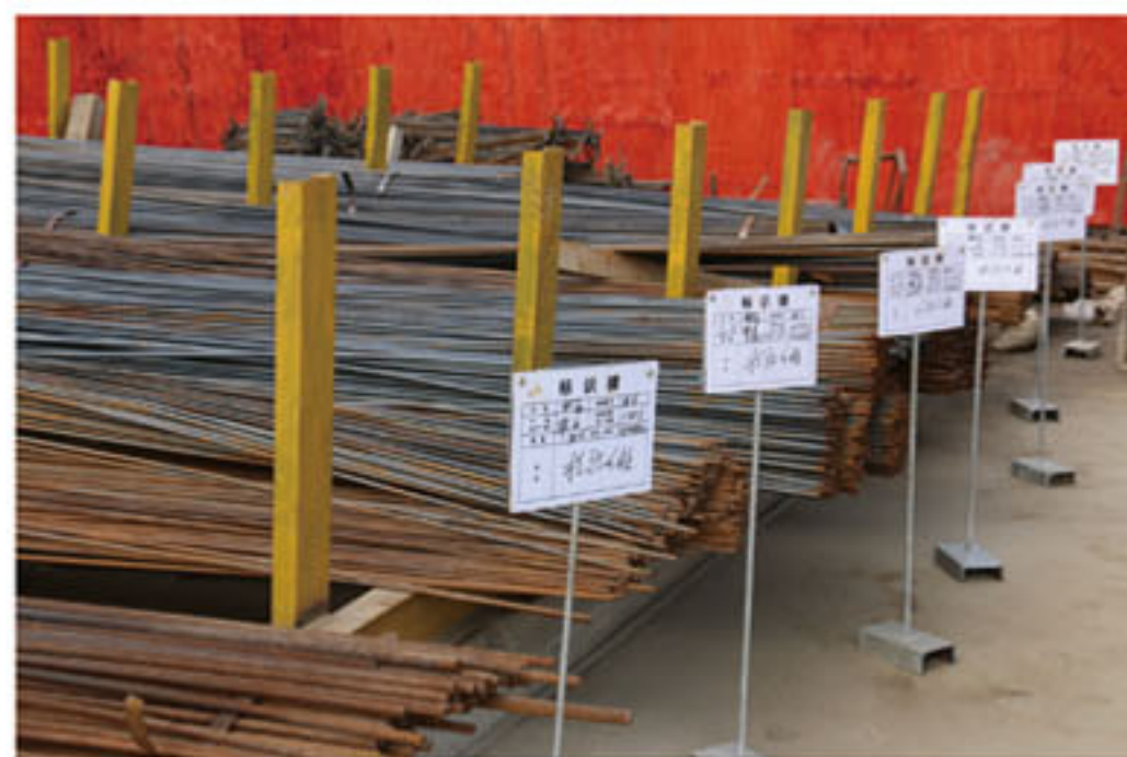
现场材料堆放整齐、标识清楚
