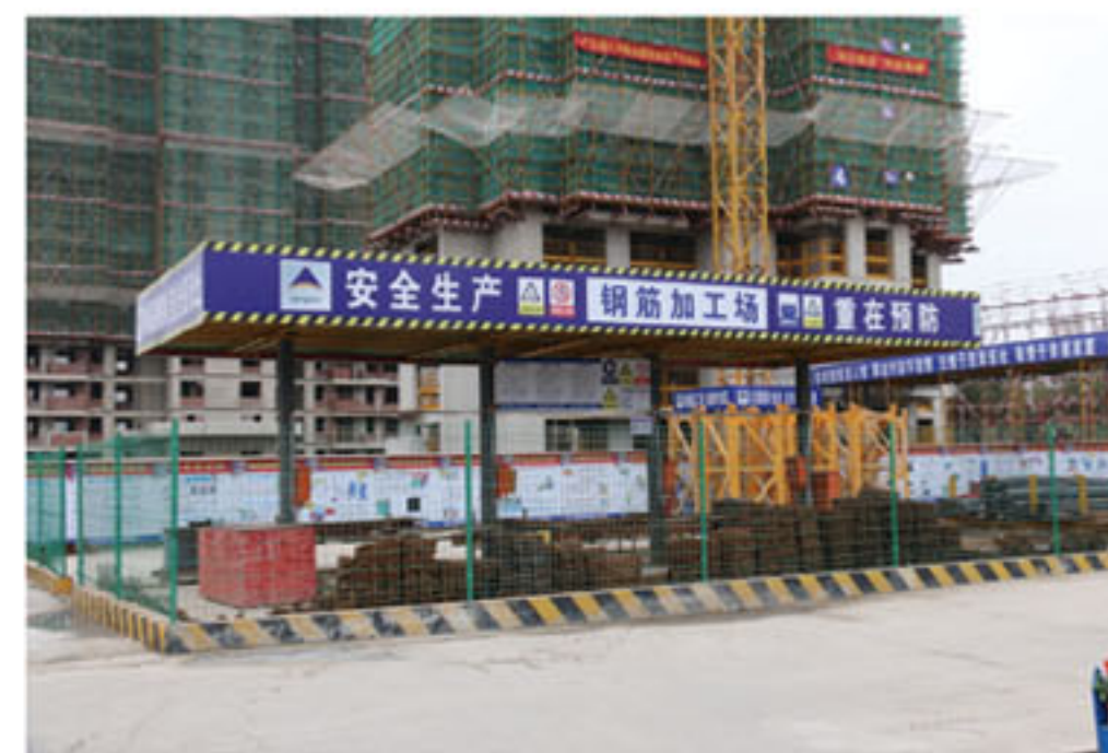
钢筋加工场防护棚
