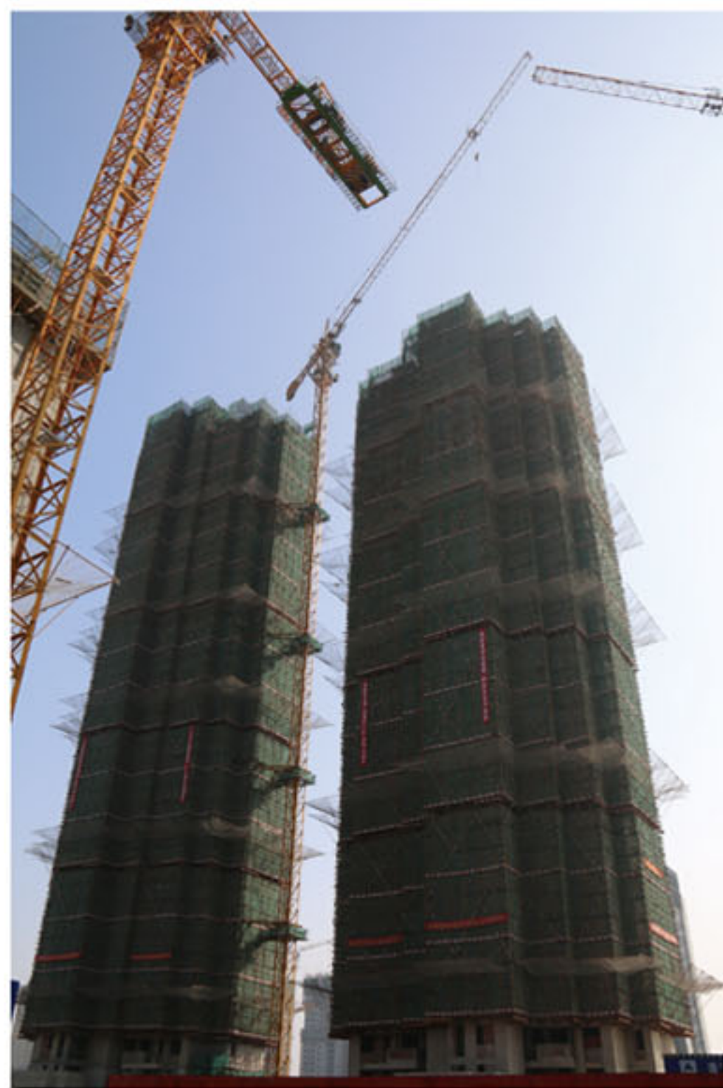
1、2#楼外架形象全貌
