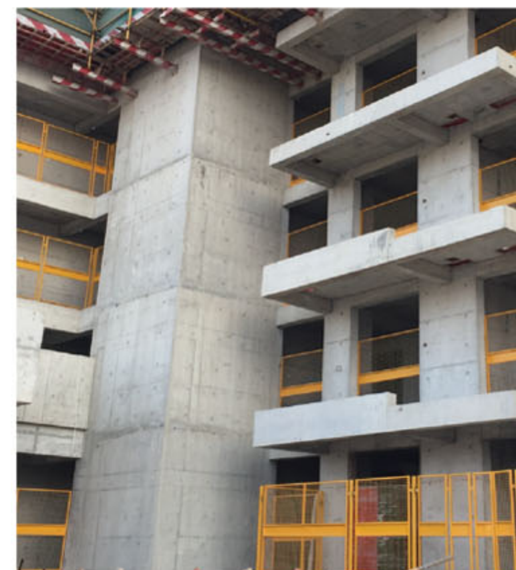
工具化定型化楼层临边防护外景
