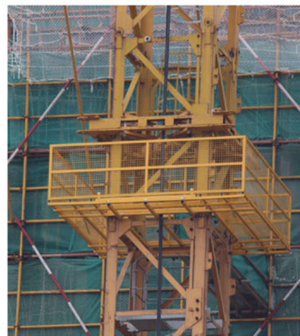
塔吊附墙操作平台
