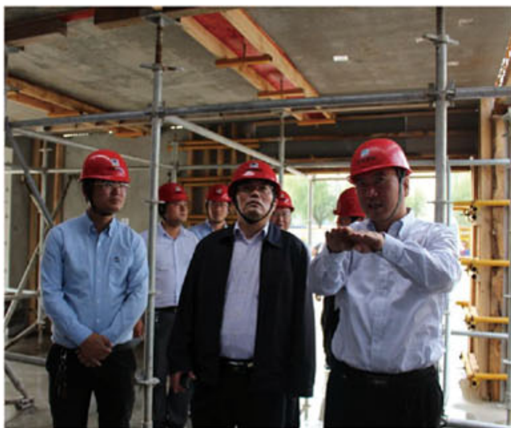
分公司经理樊裕伟向检查组领导汇报了一体化施工的预制装配式结构施工工艺、流程、与传统现浇结构的对比优势
