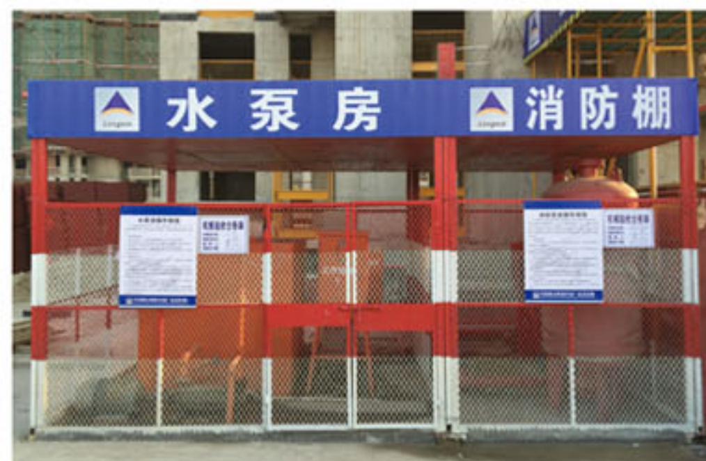
消防水泵防护棚
