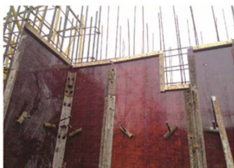
附图：钢框竹胶模墙板
